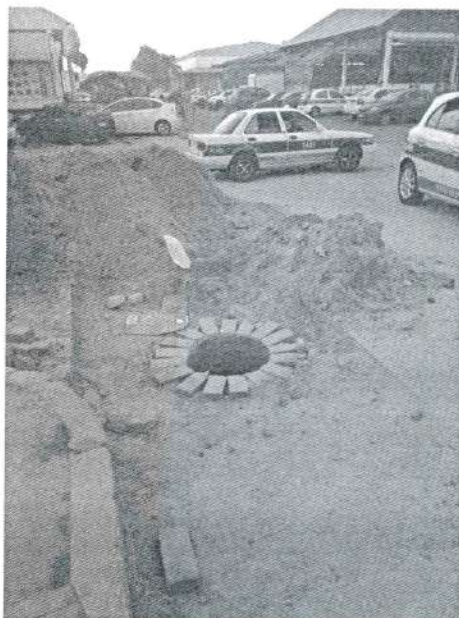
Concepto de obra ejecutado: construcción de pozo de visita sanitario
