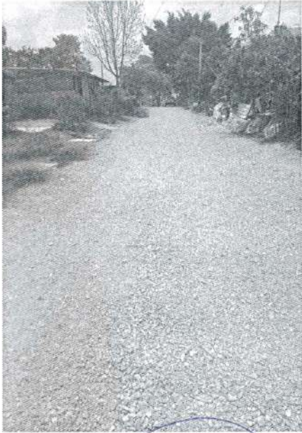
Concepto de obra ejecutado: tendido de caliza en calle Córdoba
