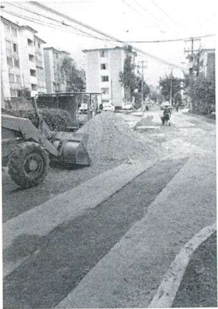
Concepto de obra ejecutado: colocación de base cementada
