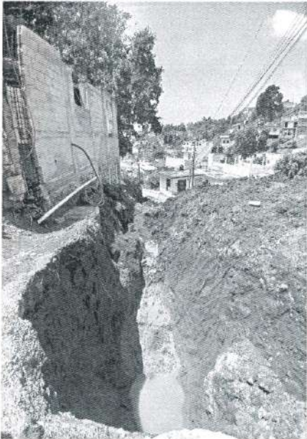
Excavación para rehabilitación de drenaje sanitario
