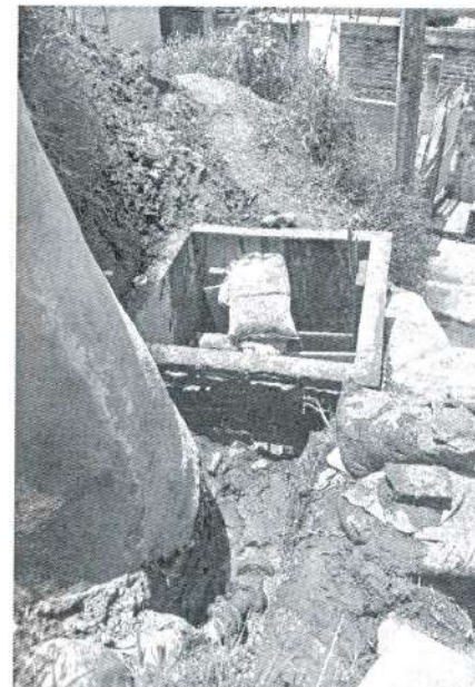
Construcción de caja de Valvulas
