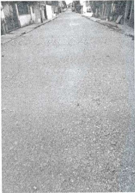
Concepto de obra ejecutado: tendido de material calizo
