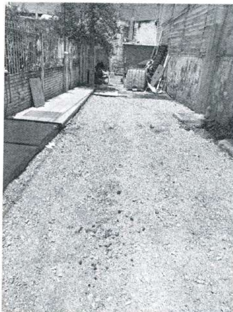
Concepto de obra ejecutado: colocación de caliza en tramo rehabilitado
