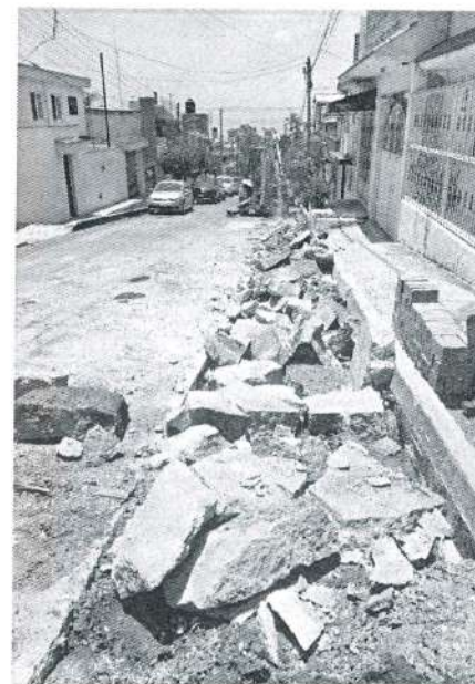
Concepto de obra ejecutado: demolición de concreto hidráulico
