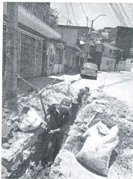
Concepto de obra ejecutado: Excavación de forma manual en material común
