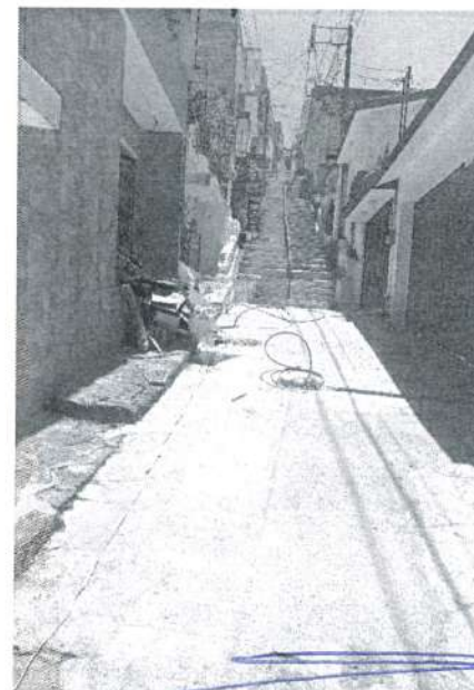
Concepto de obra ejecutado: Reposición de pavimento y escalinatas de concreto
