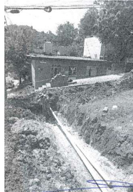
Concepto de obra ejecutado: Instalación de tubería de PVC RD-26 de 3" de diámetro sobre calle Delfino Victoria
