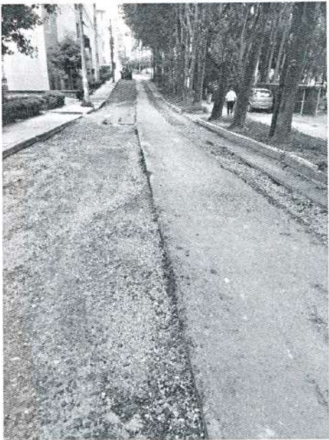
Concepto de obra ejecutado: colocación de base para recibir el pavimento asfáltico
