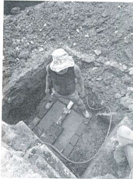
Concepto de obra ejecutado: Construcción de caja de desfogue
