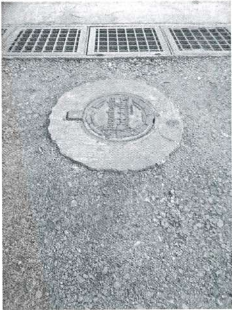
Concepto de obra ejecutado: instalación de brocal de polietileno
